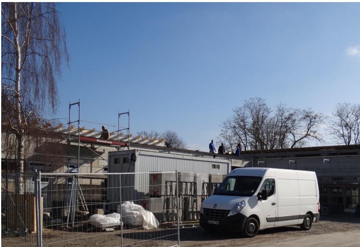
Baustelle der KITA „Zwergengarten“ in Klockenhagen im März 2024.
