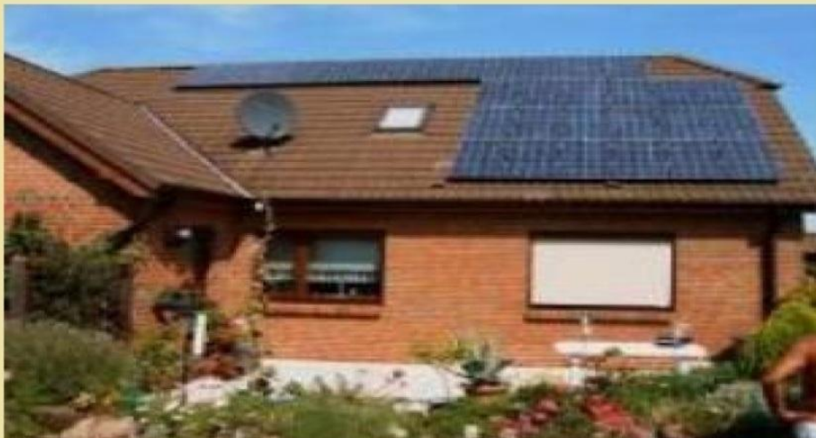
Mit der Sonne Geld verdienen! Eine Solaranlage auf dem Dach eines Einfamilienhauses in Ribnitz-Damgarten. Foto: Eckart Kreitlow
